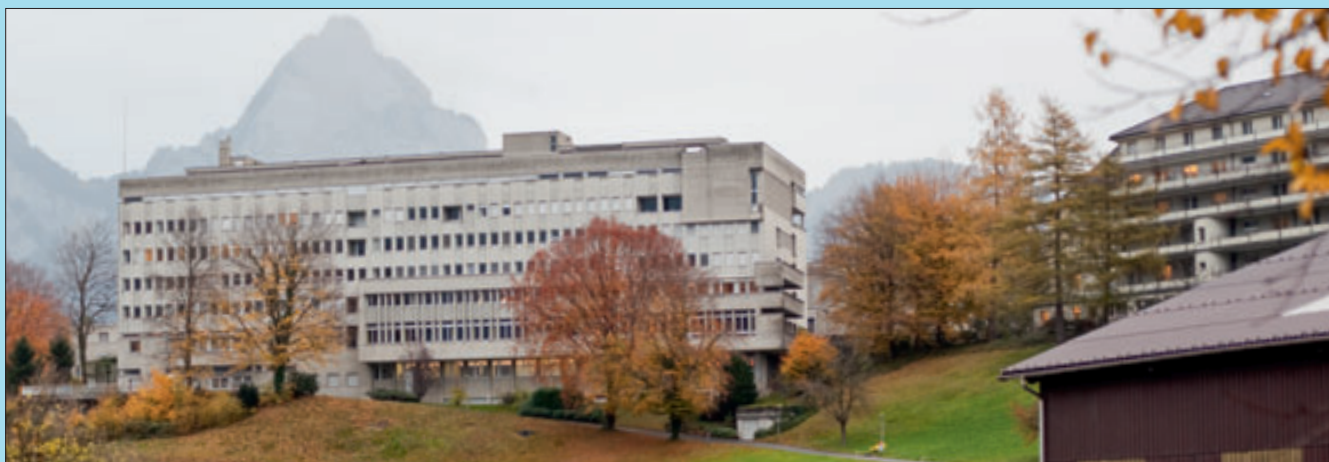
Maison-mère des Sœurs d'Ingenbohl (siège central pour toutes les Sœurs de Charité de la Sainte-Croix actives dans le monde entier). Sur le côté droit, on peut apercevoir une partie de la maison de soins Saint Joseph pour les Sœurs.
