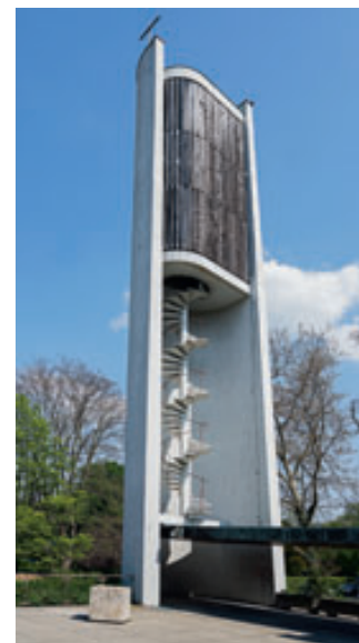
Le clocher avec son escalier circulaire est indépendant et est relié à l'église par une entrée couverte.
