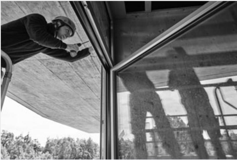
*Afin de garantir la séparation des matériaux selon leur type lors du démantèlement, pour la plupart des raccords à vis ont été utilisés dans la construction du module Sprint.*
