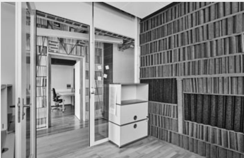
*Différents types de cloisons sont utilisés dans le module Sprint, qui peuvent être à nouveau démontés si nécessaire. Les matériaux utilisés comprennent des livres d'occasion et des dalles de moquette.*
