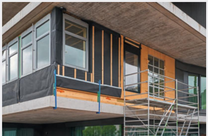
Dans le projet Sprint, des boîtes ont été intégrées à la façade pour définir la zone des fenêtres. Ceux-ci font passer la dimension et l'apparence des fenêtres au second plan, ce qui augmente considérablement la flexibilité lors de l'installation de fenêtres réutilisées.
