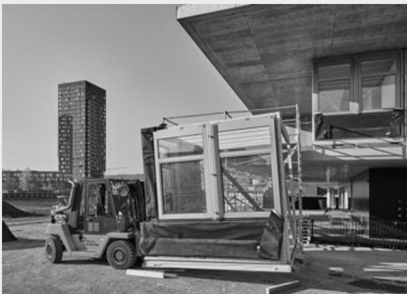
Les modules préfabriqués en bois ont été soulevés par un chariot élévateur sur la plateforme la plus basse du bâtiment NEST sur le campus de l'Empa.
