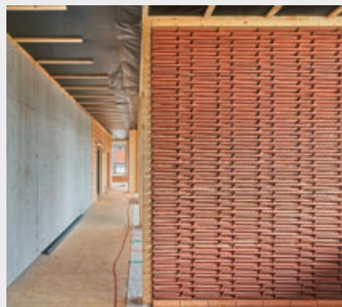
L'une des cloisons des bureaux du module Sprint est faite de briques qui auraient fini en déchets dans une décharge. Afin de pouvoir les séparer par type lors de leur démantèlement, elles ont été maçonneries à l'aide d'argile.
