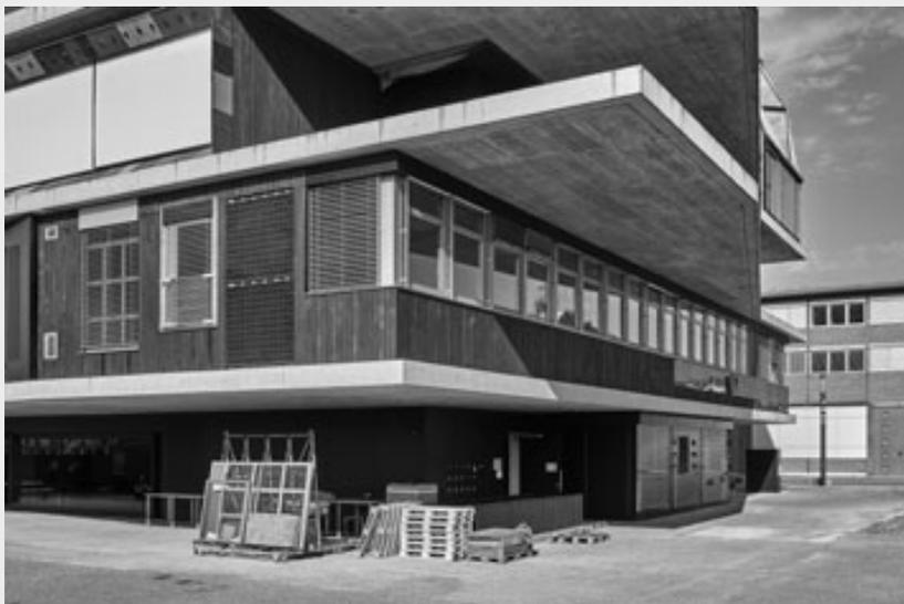
*Pour la façade du module Sprint, les lattes de bois de la «backbone» NEST, qui ont été démontées lors de l'insertion du nouveau module, ont été réutilisées. Les modules PV proviennent de projets passés.*
