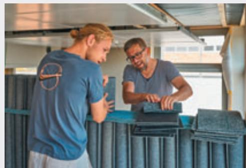
Le mur de moquette innovant spécialement conçu pour le module Sprint est entièrement constitué de dalles de moquette recyclées et peut être entièrement démonté après utilisation. Le mur de moquette a été testé pour son isolation aux bruits aériens dans le laboratoire d'acoustique de l'Empa et fait maintenant l'objet d'essais pratiques dans le module.
